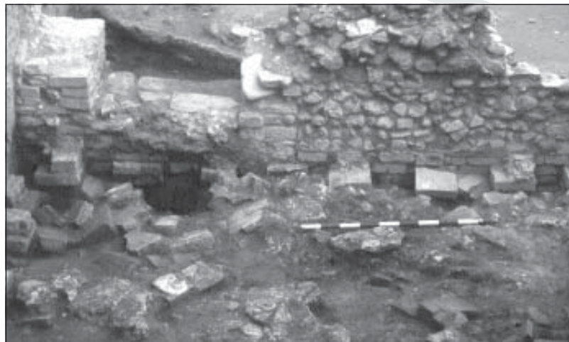
● Muro que separa las estancias A y B. A la izquierda el paso de puerta, con el arco de ladrillos por debajo, sin terminar de excavar. Nótese los ladrillos salientes o suspensurae
