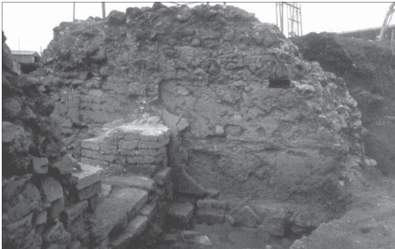
Estancia B. Paramento enfoscado con cal junto al paso de la puerta
